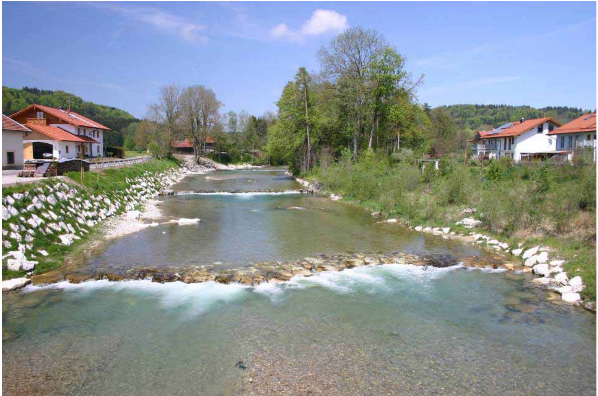
Částečné revitalizace řeky Mangfall v Bavorsku
