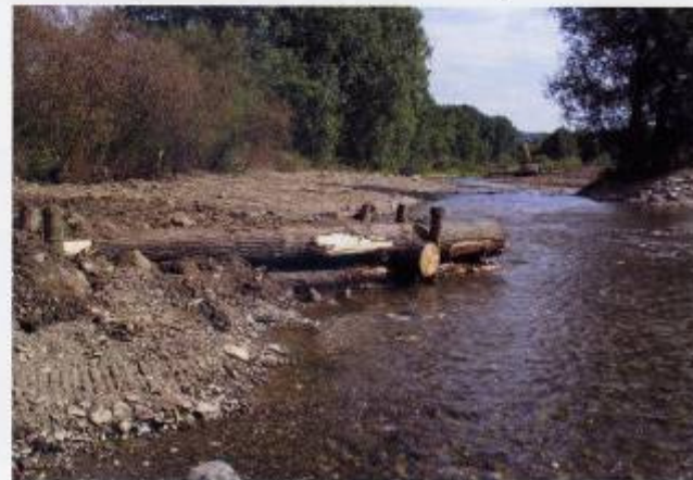
Massiver Strömunglenker an der Ahr.
