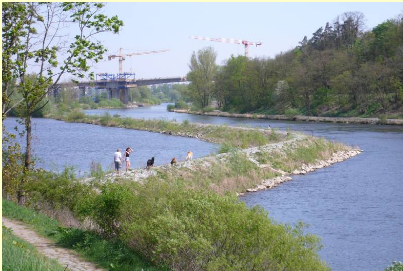
Koncentrační hráz na Vltavě u Zbraslavi – obnovena po povodni 2002
