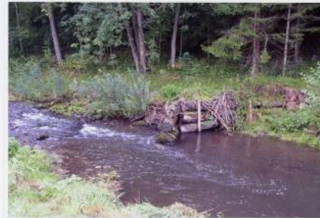
Strömunglenker an der Elz nach einigen Jahren.
