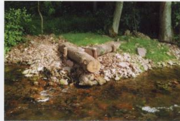
Strömunglenker an der Elz
